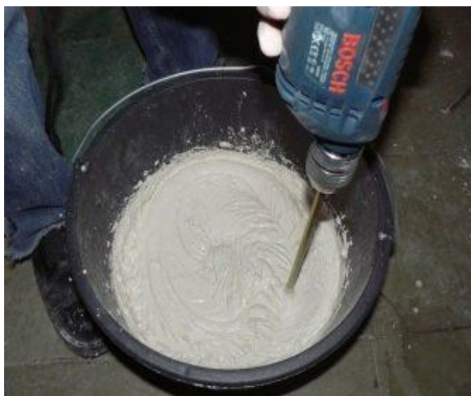
Рисунок 4.1 – Приготовление ремонтного материала
