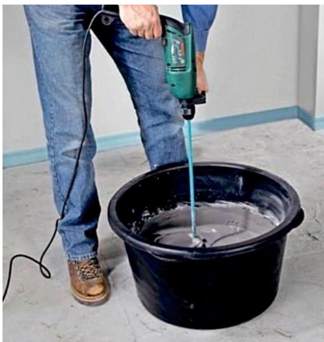
Рисунок 4.1 - Перемешивание гидроизоляционной смеси с помощью электродрели с насадкой
