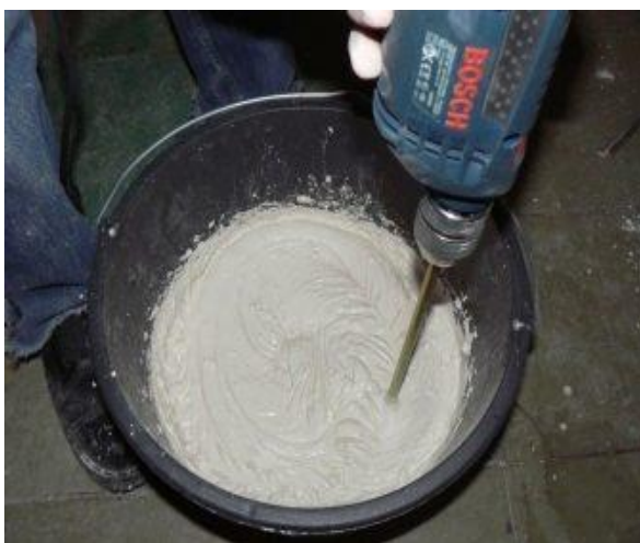
Рисунок 4.3 – Приготовление ремонтного материала РС 16
