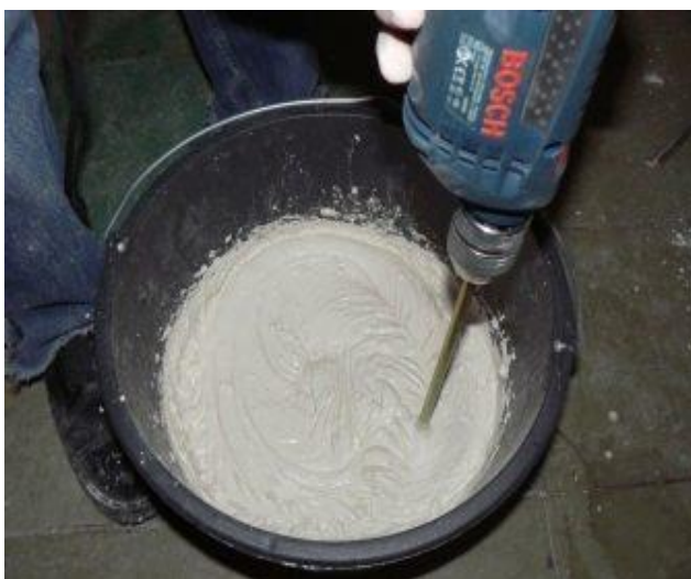
Рисунок 4.1 – Приготовление ремонтного материала РС 3
