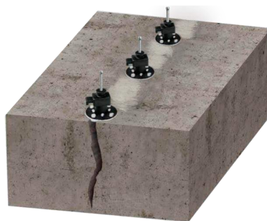
б – герметизация трещины
