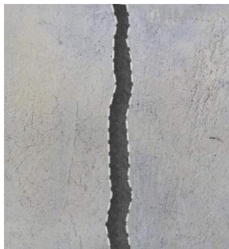
б – устройство штрабы
