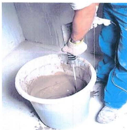
Рисунок 11 - Перемешивание состава Гард с помощью электродрели с насадкой
