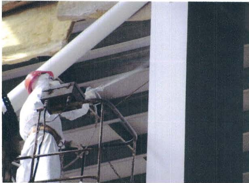
Рисунок 12 - Нанесение огнезащитного состава на металлические поверхности металлоконструкций методом безвоздушного распыления
