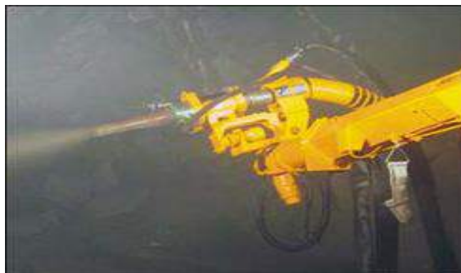
Автоматическая торкрет-головка при механизированном торкретировании с применением торкрет-установки
