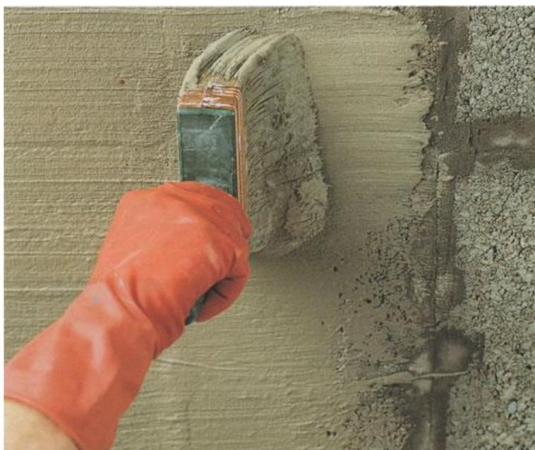
Рисунок 4.4 – Нанесение гидроизоляционного материала «ГС Пронитрат» кистью
