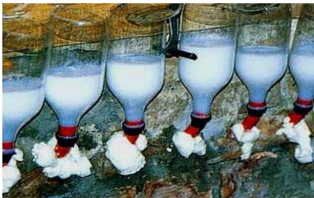
Рисунок 4.7 – Инъекция «ГС Пронитрат Инъекционный» без давления
