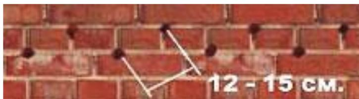
Рисунок 4.6 – Схема размещения шпуров
