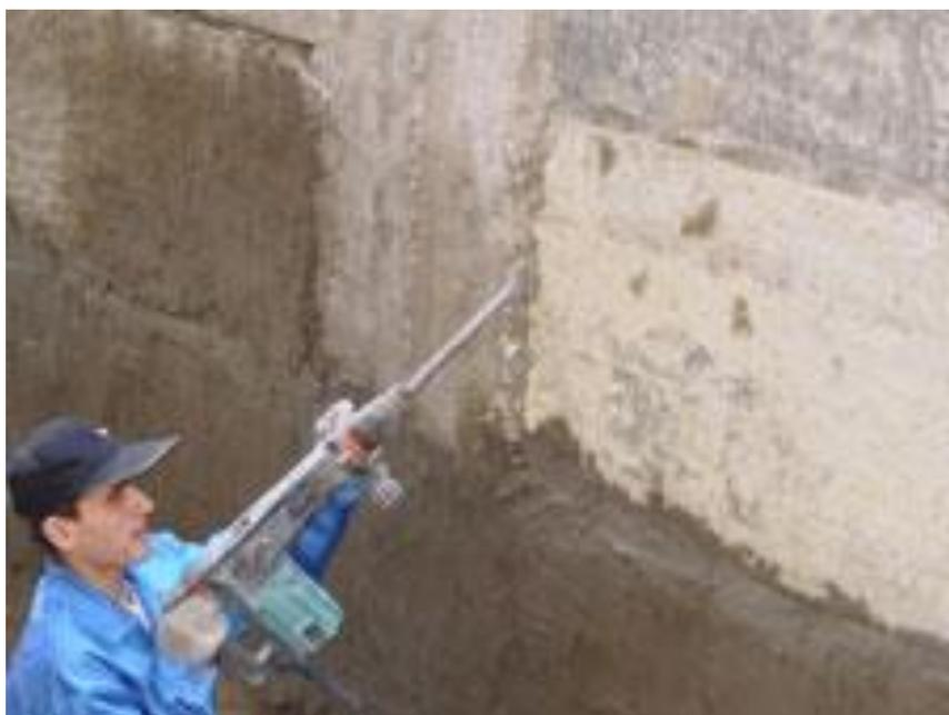
Рисунок 4.1 – Расшивка шва электроперфоратором
